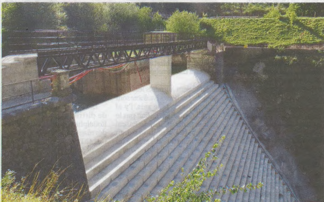
Le barrage a été renforcé avec un parement aval en forme d'escalier. Une première en France. © O.I.
